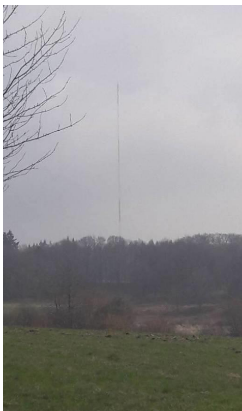
Photo 1 : Mât installé sur site
